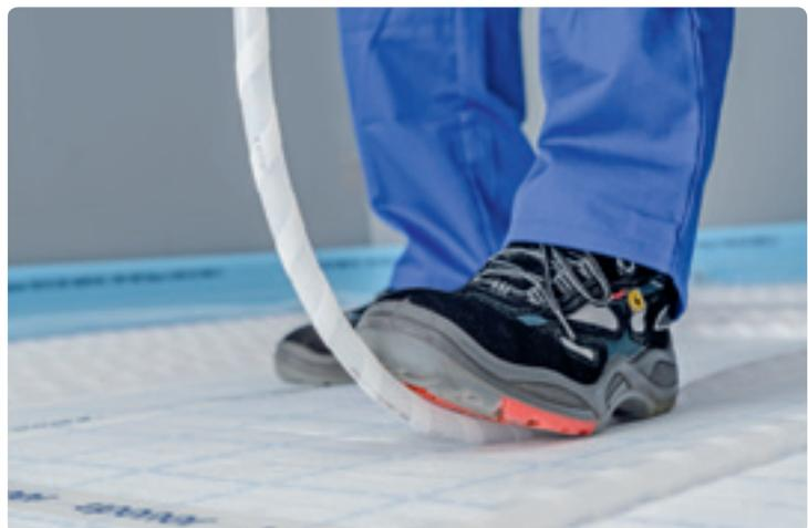
So einfach kann Fußbodenheizungsverlegung sein - Rohrbefestigung mit dem Fuß und ohne Verlegehilfsmittel und Werkzeuge
