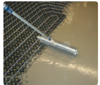
Egalisieren und entlüften der Verfüllmasse mit einer Stachelwalze
