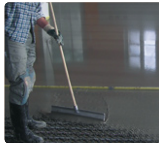
Verteilen der Verfüllmasse (Rohrüberdeckung mind. 5 mm)
