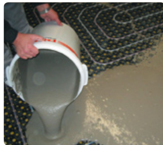
Ausgießen der PCI-Bodenausgleichsmasse zum Verfüllen des Heizungssystems
