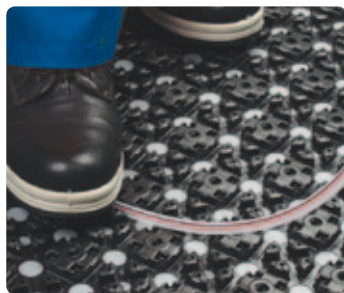
Praktische Ein-Mann-Montage der Uponor Velta PE-Xa Rohre
